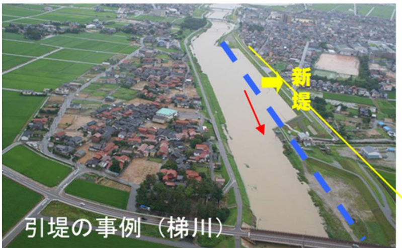
引堤の事例(梯川)
