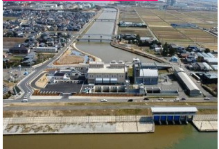
排水機場と周辺の市街地
