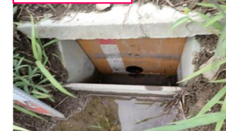
流出調整板設置の例
