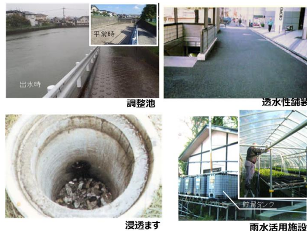
雨水貯留浸透施設の例
