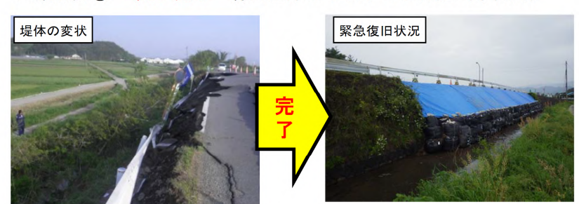
■ 緊急災② 4/23 完了 緑川左岸 2 0 k 7 0 0 付近 (甲佐町)
