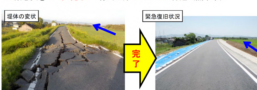
■ 緊急災⑤ 5/1完了 緑川左岸 8 k 4 0 0 付近 (熊本市)
