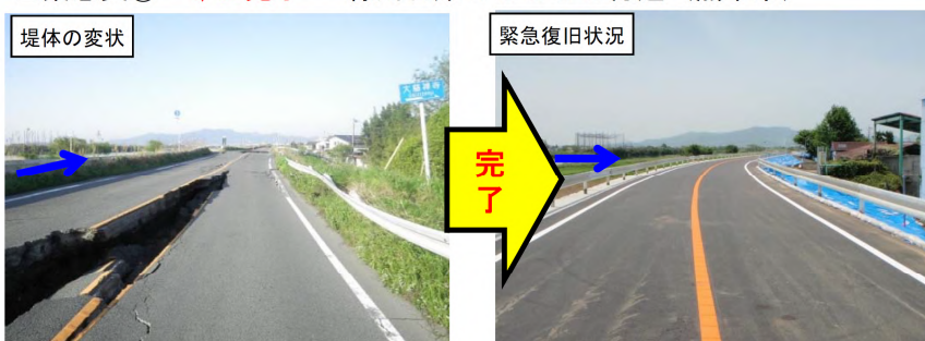
■ 緊急災④ 4/30完了 緑川右岸 8 k 9 0 0 付近 (熊本市)
