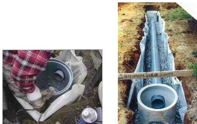
図 7-6 浸透ます、透水管の据付 7-7
