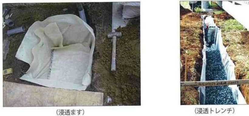
図 7-5 充填砕石の施工
