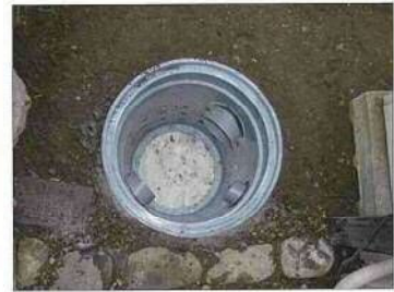
図 7-9 埋戻し状況
