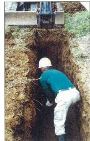
図 7-1 掘削状況 (浸透トレンチ)
