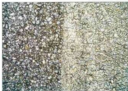
図 8-4 透水性舗装清掃後(右)と清掃前(左)
