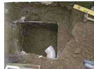
図 7-2 掘削状況 (浸透ます)
