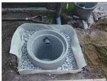
図 7-7 充填砕石工の完了
