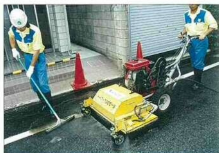
図 8-3 透水性舗装の清掃状況
