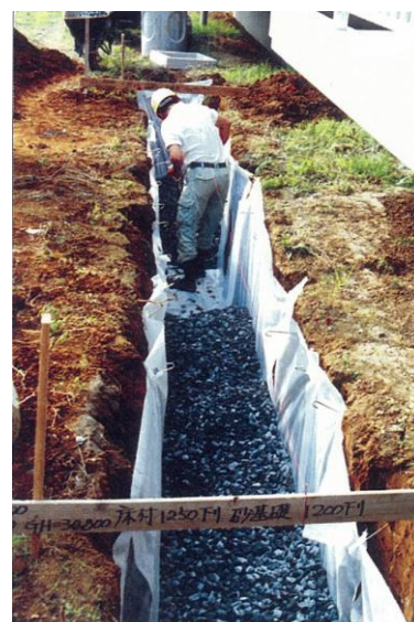
図 8-3 充填碎石の施工
