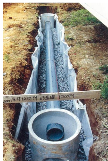
図 8-5 充填砕石工の完了
