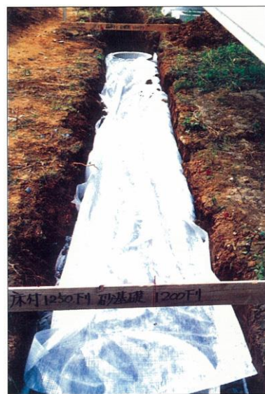
図 8-6 透水シート覆工後の状況
