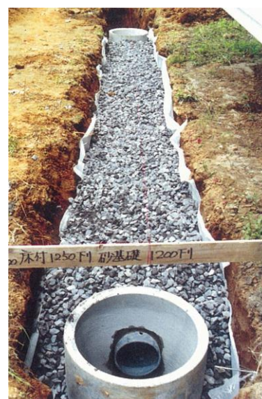
図 8-4 ます、透水管の据付
