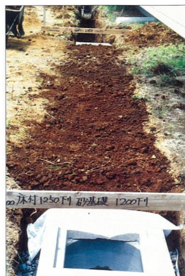
図 8-7 埋戻し状況
