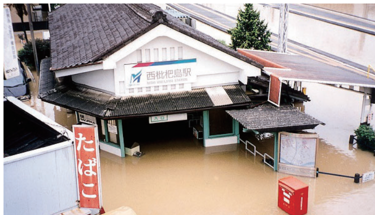
東海豪雨では新川が決壊し甚大な被害が生じた
