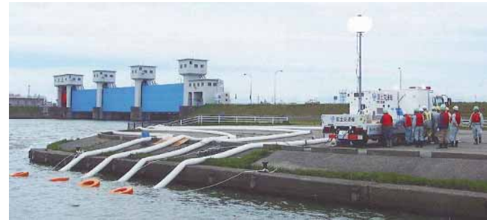
排水ポンプ車の稼働光景(イメージ)
