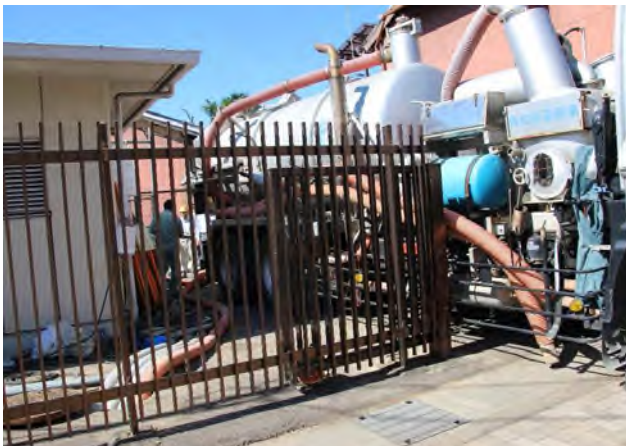
中間立坑からのポンプ車による浸水堆積物の排出状況
