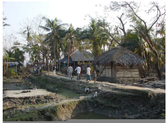
写真－２４ 堤内地の被災状況 （左：崩壊した家屋の跡、右：復旧した家屋）
