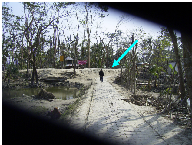
写真-33 最南端の堤防 (堤内地から撮影)
