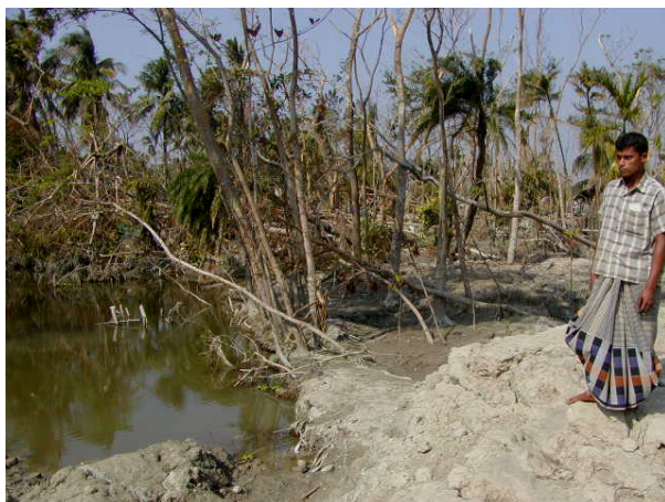
写真－２９ 堤内地の被災状況
