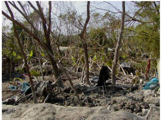
写真－２８ 堤内地の被災状況
