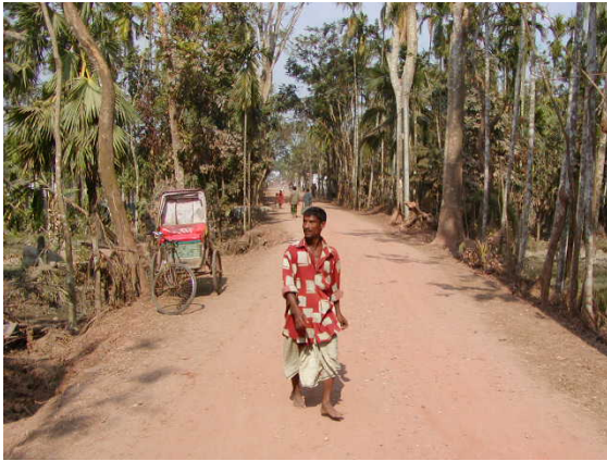
写真－１ 道路の現状
