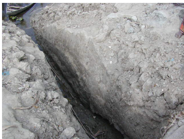
写真-41 堤防断面
