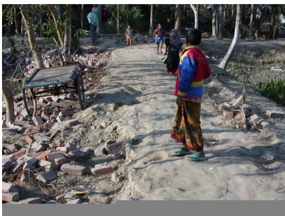
写真－２５ 道路舗装のレンガ
