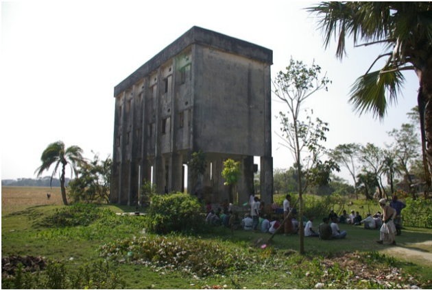
写真－１６ サイクロンシェルター全景
