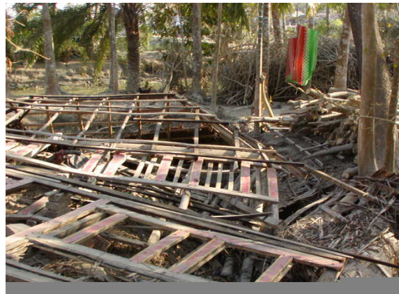
写真－２６ 破損した家屋
