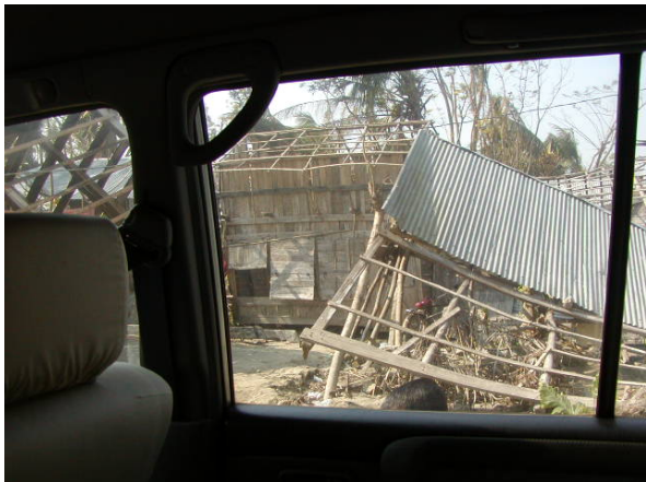
写真－ 7 倒壊した家屋
