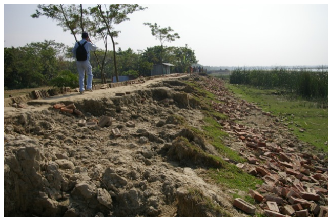
写真－１５ 河川沿いのレンガ被覆の Union 連絡道路の被災状況
