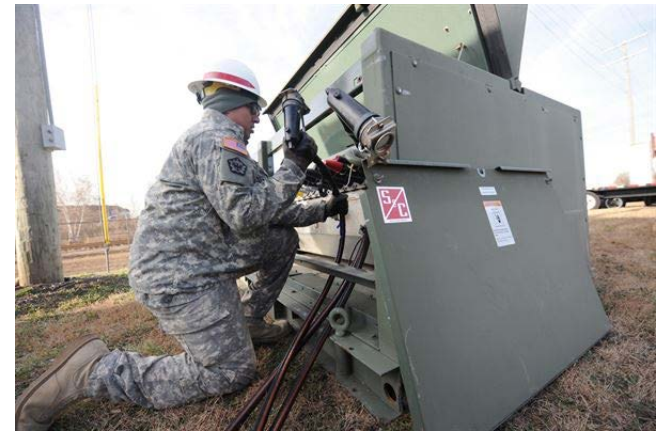
工兵隊による非常用発電機の設置
