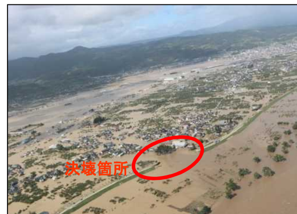
浸水状況(10月13日12時)
