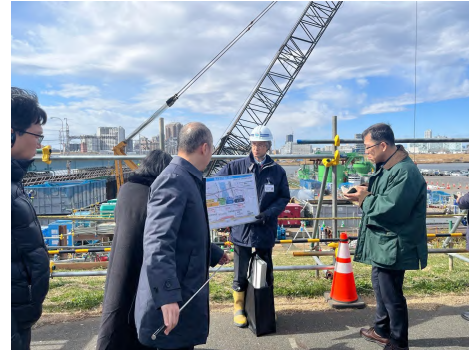
京成本線橋梁架け替え
