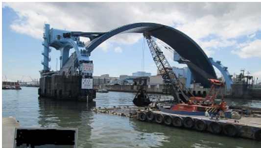
水門の開閉のための浚渫
