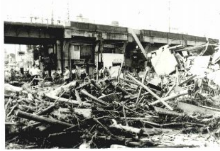
（中央区）JR高架北側の堆積土砂 （S42災害）
