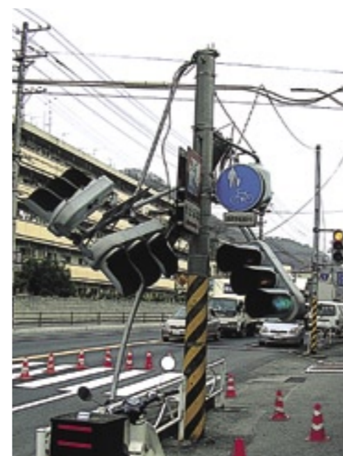
〔左〕激しい揺れで途中から折れた国道2号線の信号機(3月24日、広島県三原市)〔写真提供/読売新聞社〕 〔上〕路面に亀裂が生じた中国自動車道。地震による道路の被害は西日本各地で367カ所に及んだ(3月24日、山口県錦町)〔写真提供/読売新聞社〕 〔右上〕出火した民家に放水する消防隊員(3月24日、広島県広島市)〔写真提供/読売新聞社〕 〔右下〕建物の外壁は剝がれ落ち、歩道に散乱した(3月24日、広島県呉市)〔写真提供/読売新聞社〕
