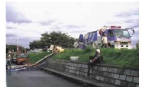
大田区からの要請で排水ポンプ車も出動。内水排除作業が行われた(9月11日、東京都大田区田園調布) [写真提供/京浜工事事務所]
