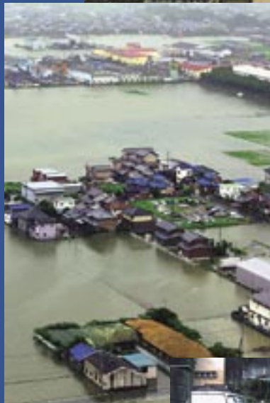
計画高水位を超えた揖斐川流域では浸水被害が相次いだ(岐阜県垂井町) [写真提供/共同通信社]
