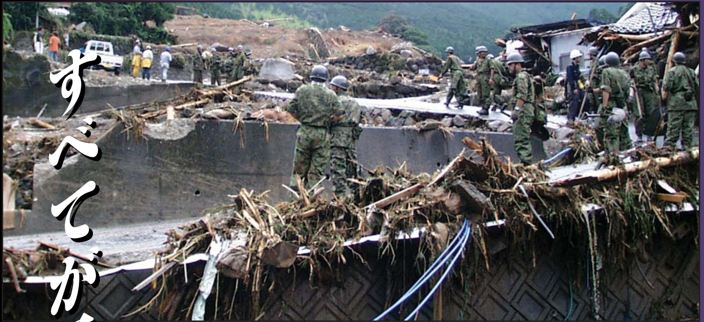
土砂災害現場での復旧活動〔写真提供／熊本県 土木部〕
