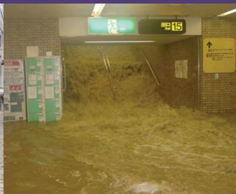
福岡市営地下鉄に流れ込む濁流 〔写真提供／九州地方整備局〕
