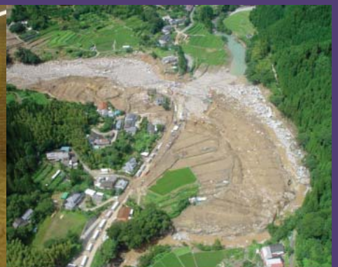
水俣市宝川内集地区の土砂災害現場 〔写真提供／九州地方整備局〕
