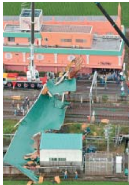
▲台風6号の強風で飛んだホテルの屋根が新幹線の架線に乗り、電線4本を切断した（滋賀県）〔写真提供／読売新聞社〕
