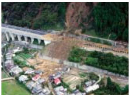
▼愛媛県新居浜市の地すべり現場（大生院地区）〔写真提供／四国地方整備局〕
