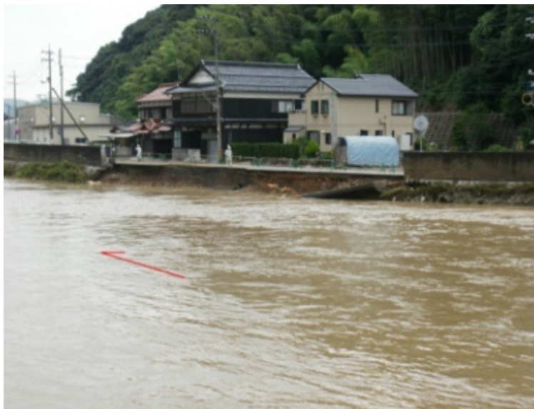
▲ 厚狭川沿川の被災状況(山陽小野田市)
