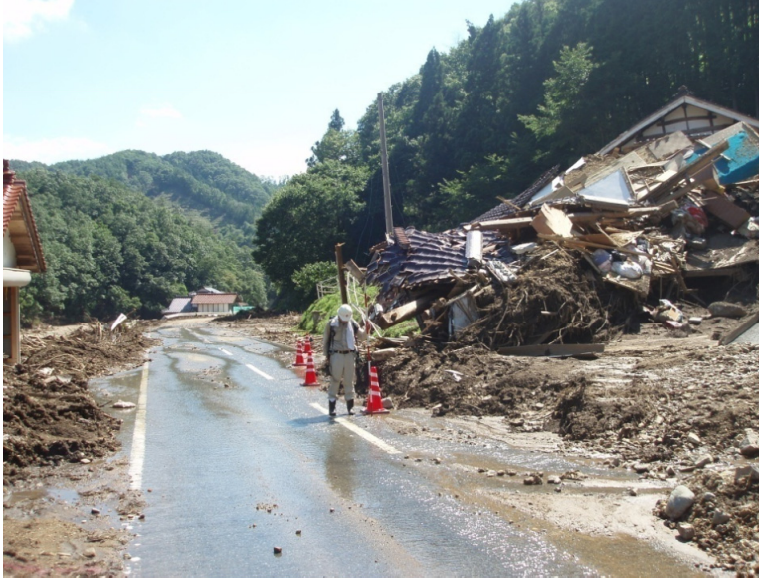
▲ 篠堂川沿川の被災状況(庄原市川北町)
