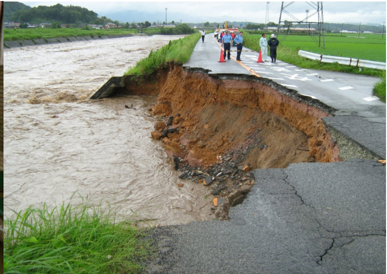
▲ 遠賀川の堤防被災箇所(嘉麻市)
