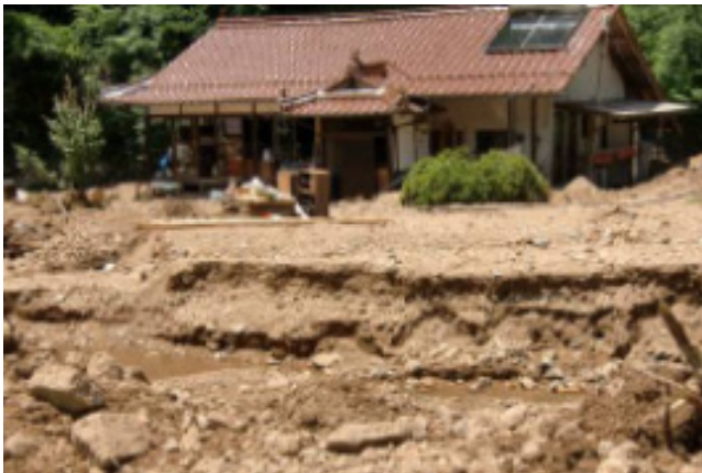
▲ 大津恵川沿川の被災状況(庄原市川北町) 篠堂川沿川の被災状況(庄原市川北町) ▶
