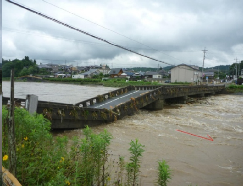
▲ 厚狭川・厚狭新橋の被災状況(山陽小野田市厚狭)
