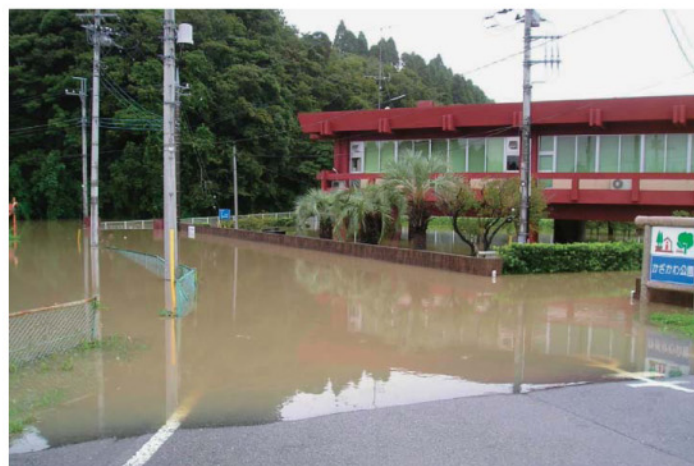
▲ 夷隅川の浸水状況（千葉県夷隅郡大多喜町）
