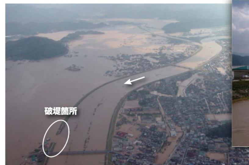
▲ 円山川右岸13.2km付近浸水状況（兵庫県豊岡市）
