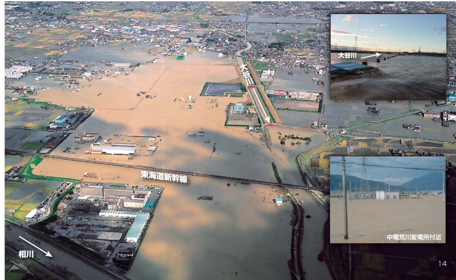
木曽川水系支川大谷川洗堰からの浸水状況（岐阜県大垣市）
