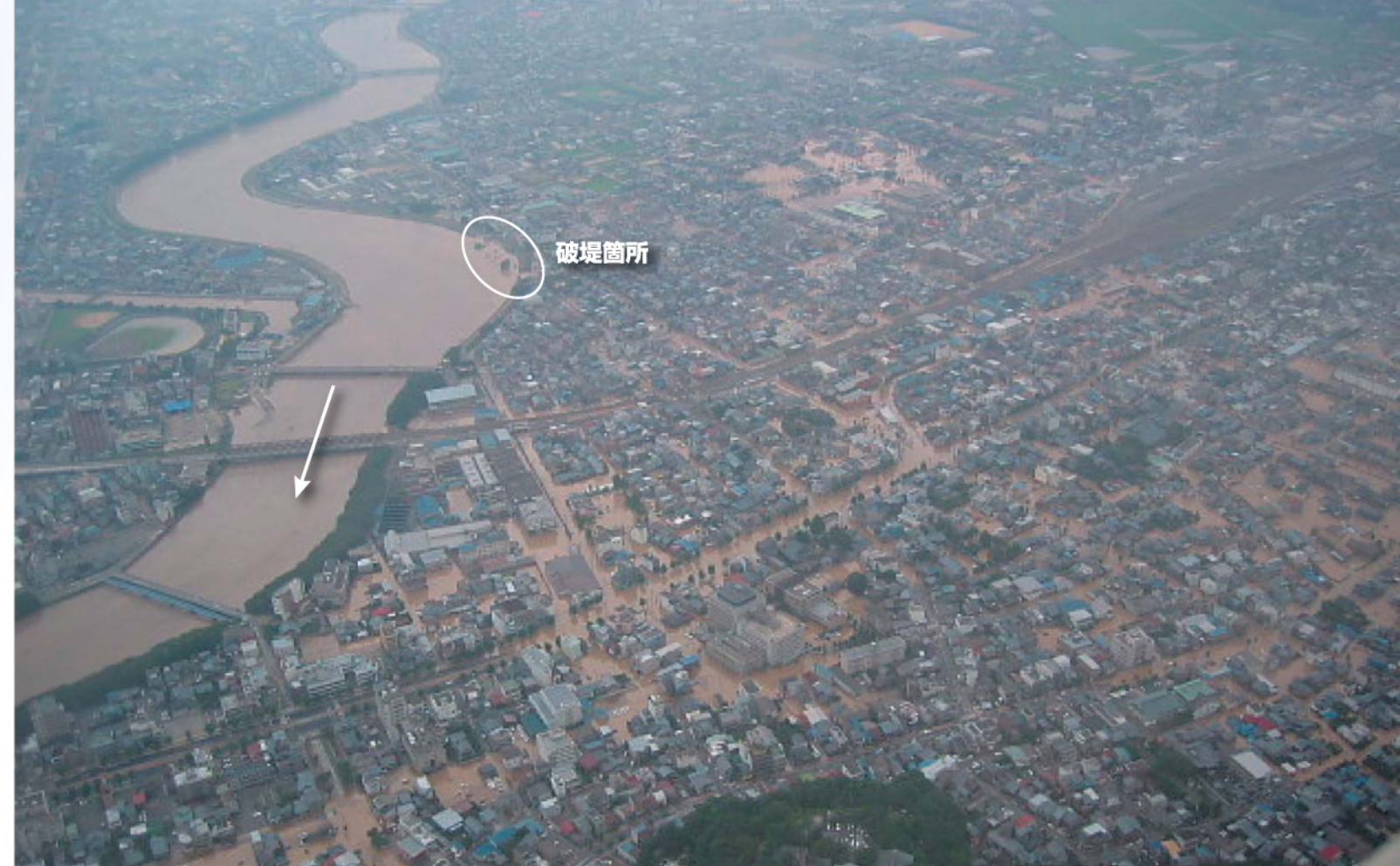
▲ 足羽川左岸浸水状況（福井県福井市）
