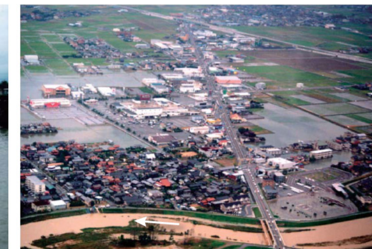
▲ 梯川5.0km右岸浸水状況（石川県小松市）
