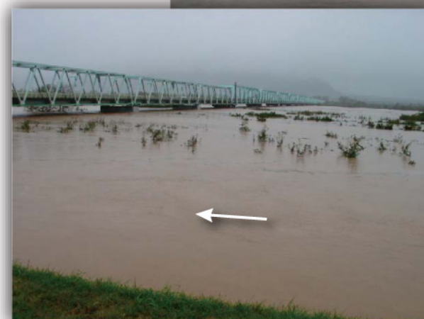
▲ 千曲川の出水状況（長野県小布施町小布施橋左岸上流）
