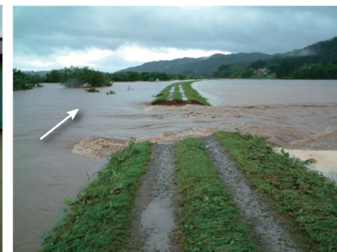
▲ 鮭川右岸破堤状況（山形県鮭川村観音寺地区）
