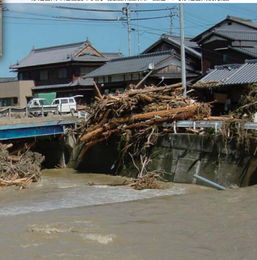
▼ 妙之谷川の氾濫後の状況（愛媛県西条市 国道11号妙之谷川橋付近）
