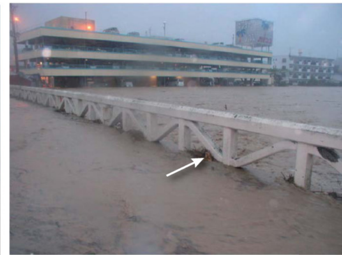
▲ 千草川の溢水状況（兵庫県洲本市物部）
