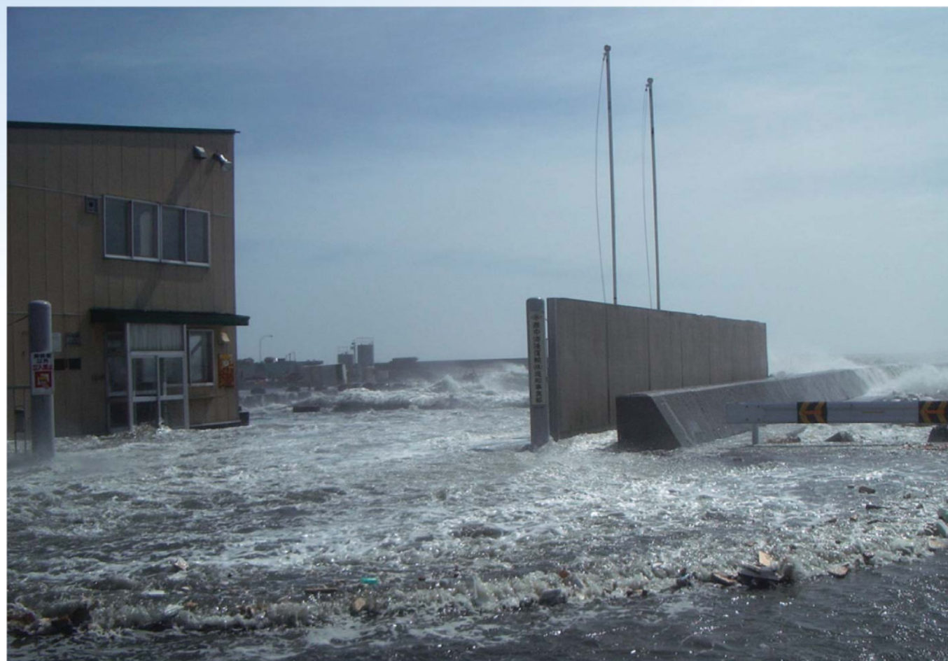
▲ 高潮による浸水状況（苫小牧港菱中造船前）
