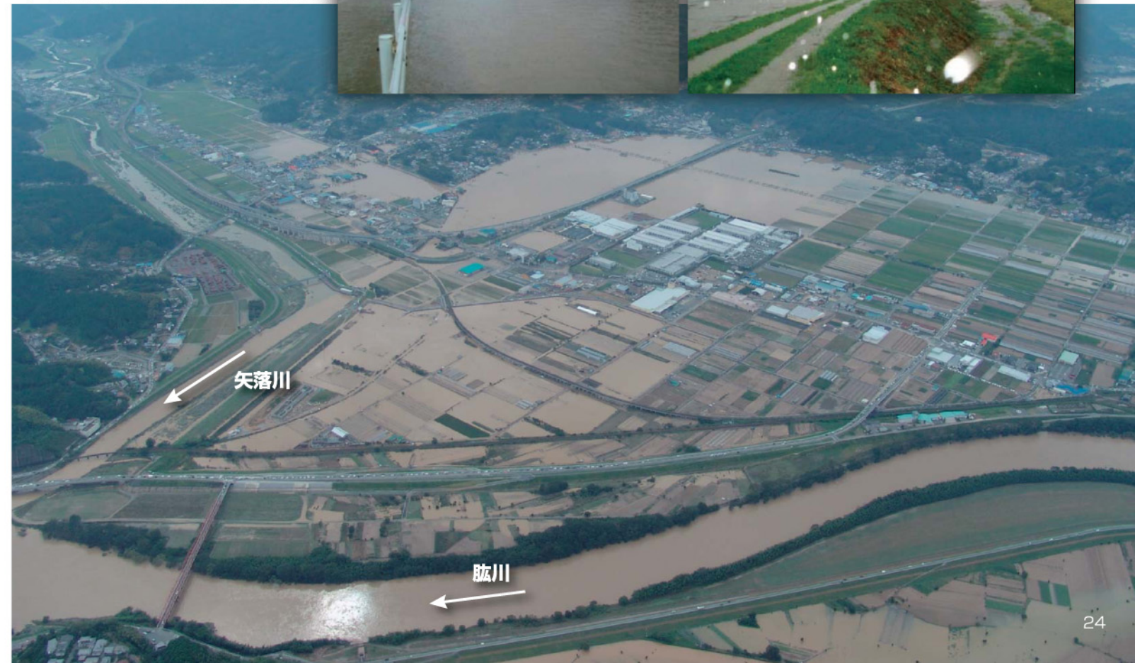
▼ 肱川大洲盆地の浸水状況（愛媛県大洲市）
