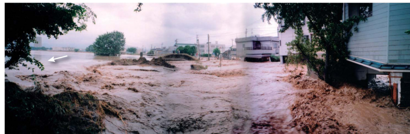
▲ 足羽川左岸破堤状況（福井県福井市）
