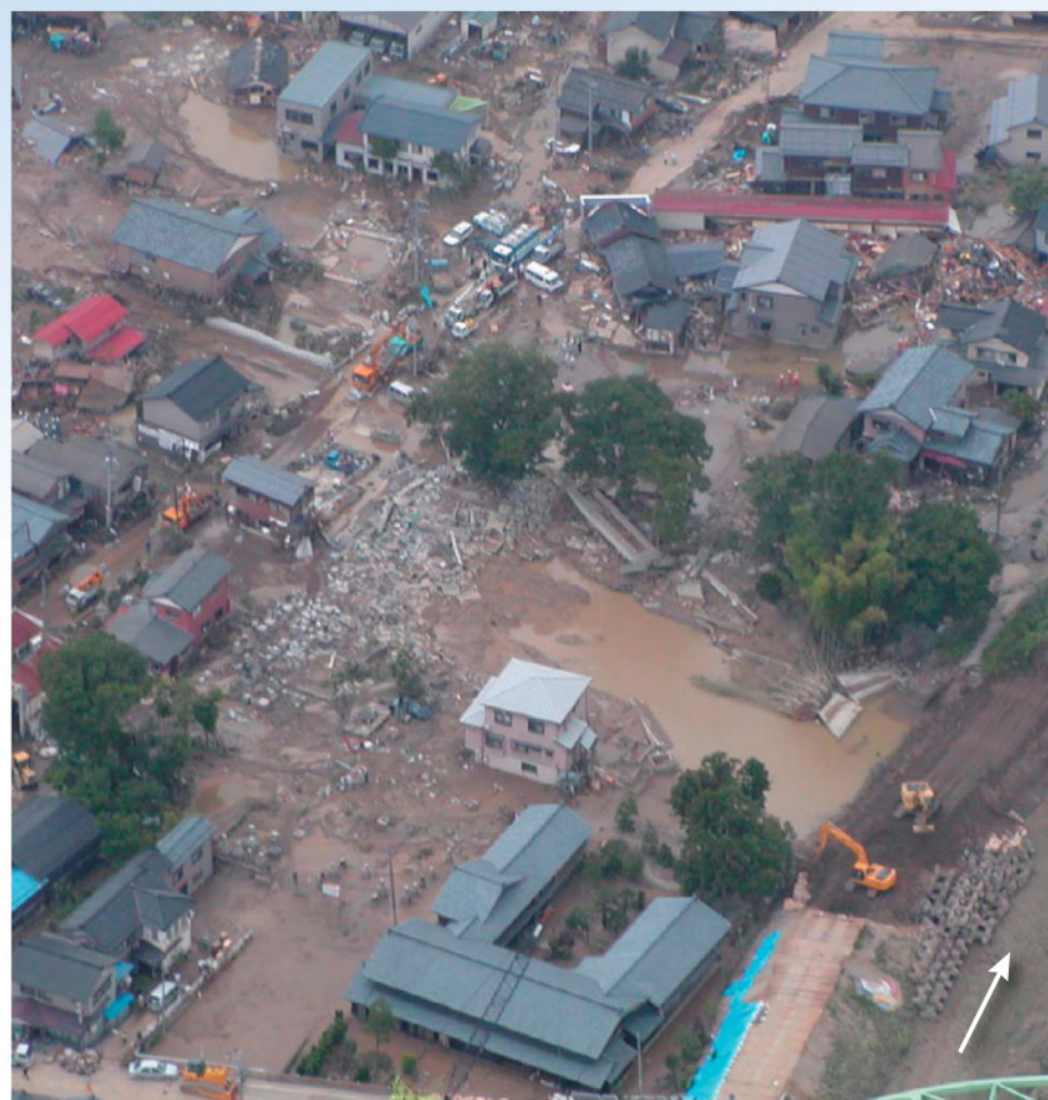
▲ 刈谷田川破堤後の状況（新潟県中之島町）
