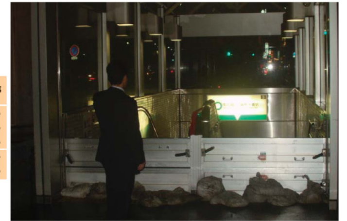
▲ 止水壁と土のうにより地下への浸水を防止（東京メトロ麻布十番駅 地上3番出入口）
