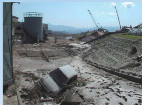
▲ 円山川の破堤後の状況（兵庫県豊岡市立野）
