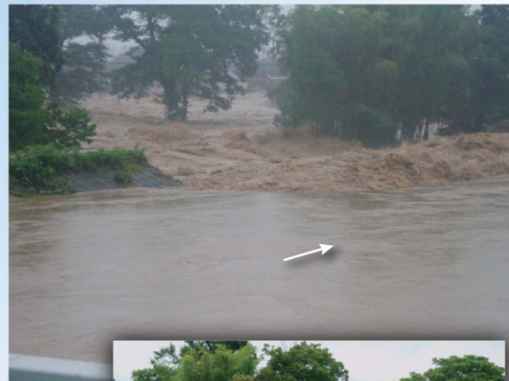
刈谷田川左岸破堤状況（新潟県中之島町）
