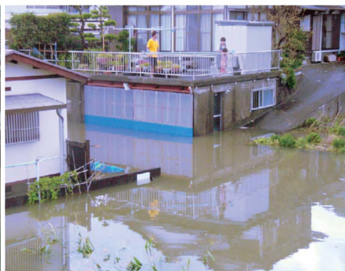
▲ 五ヶ瀬川の浸水状況（宮崎県延岡市）
