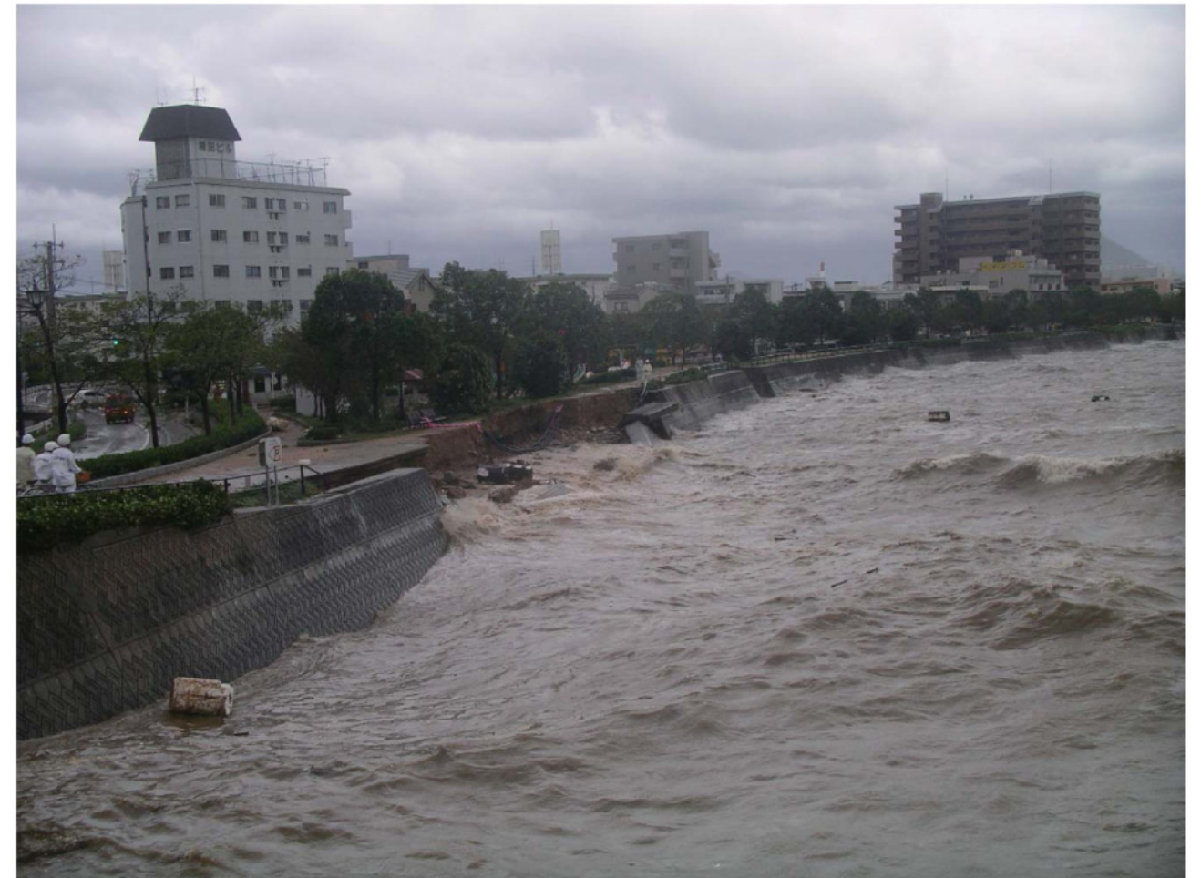
▲ 高潮による太田川堤防損壊状況（広島県広島市中区）
