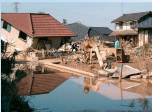
▲ 出石川の破堤後の状況（兵庫県出石町）
