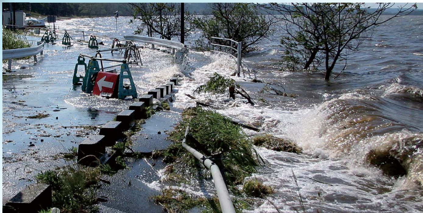
▲ 高瀬川水系小川原湖の越波の状況（青森県三沢市）
