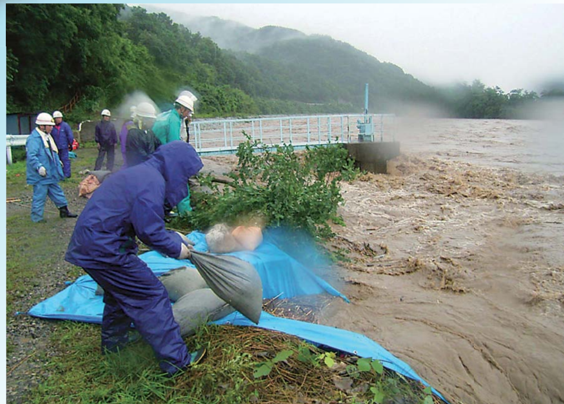
▲ 信濃川支川犀川の防水活動状況（長野県生坂村）
