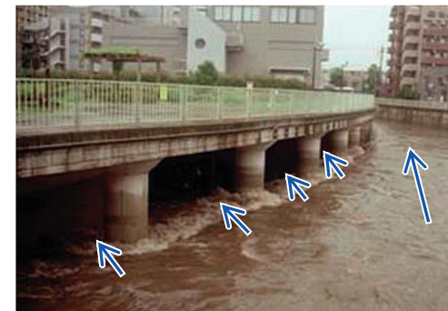
▲ 環七地下調節池への洪水流入状況（H15.6）
