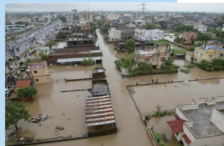
▲ モンスーンによる河川のはん濫で浸水したAhmedabad市内（インド）
