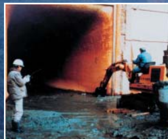
洪水吐、ゲート等放流施設の改良および新設
