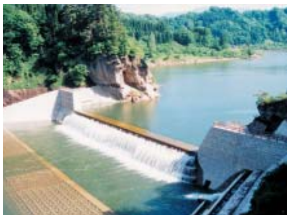
貯砂ダムの設置
