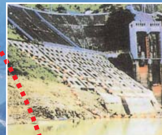
ダム本体付近の大規模な地山安定工事等
