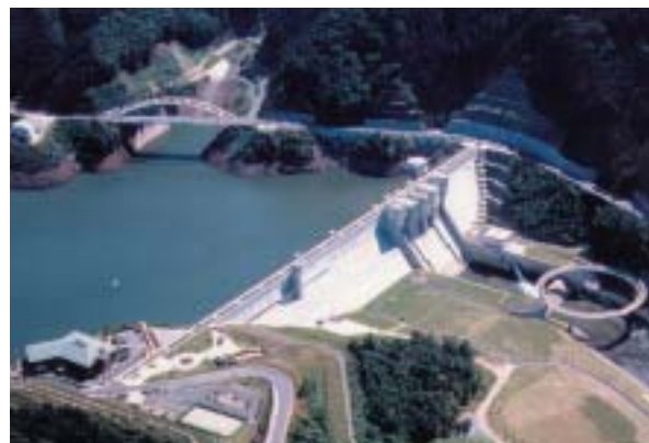
上下流交流のために開かれた堤体と広場（日吉ダム、水資源機構）
