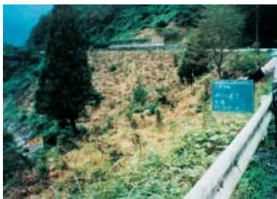
貯水池周辺の裸地での植栽施工直後の状況
