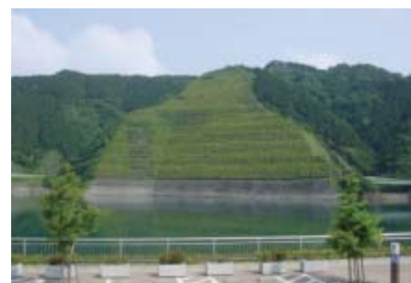
貯水池法面の緑化
