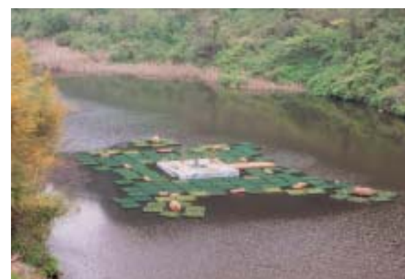
耶馬溪ダム（九州地方整備局）の水質浄化人工浮島
