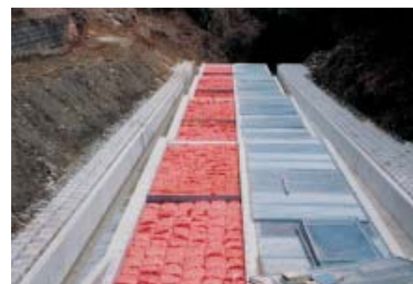
支川へのリン吸着材の敷設
