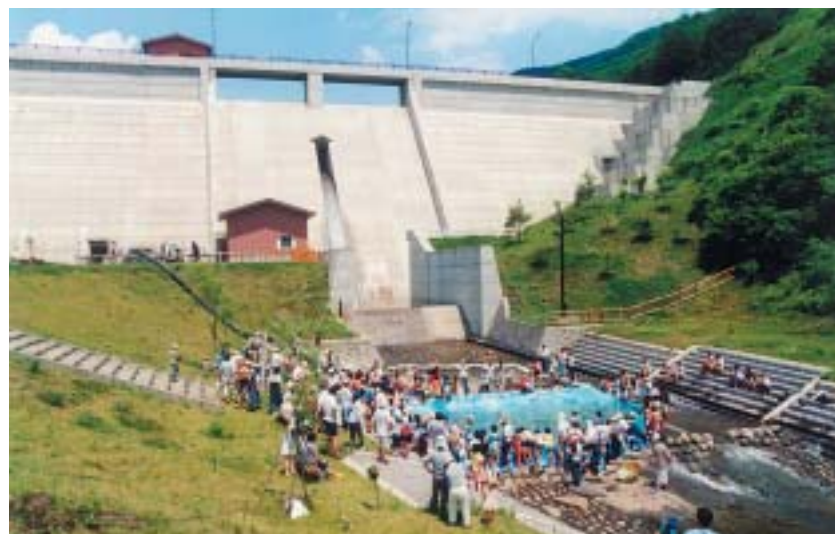
地域に開かれたダム（田島ダム、福島県）
