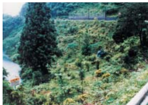
貯水池周辺の裸地への植栽施工後約2年の状況
