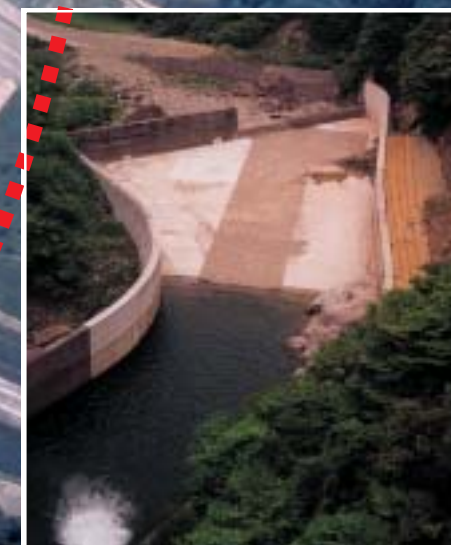
減勢工の改良および新設
