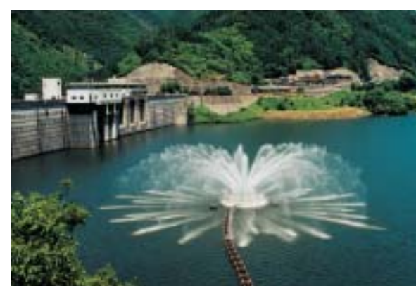
貯水池で噴水を兼ねた浅層曝気
