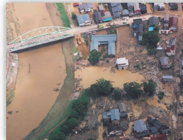
新潟・福島豪雨による堤防決壊(刈谷田川)
