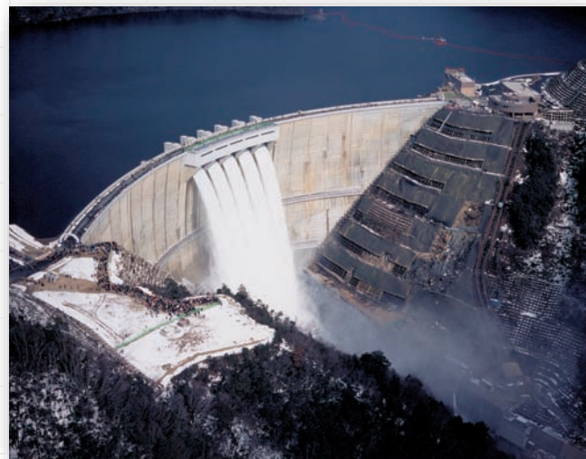
温井ダム(中国地方整備局)
