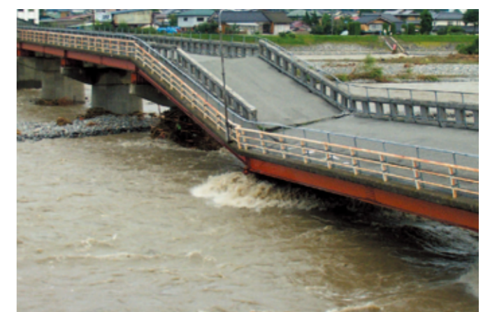
H18.7月豪雨 天竜川の橋梁被災状況(長野県伊那市)
