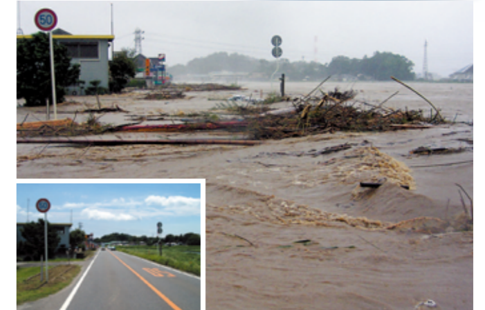
H17台風14号の増水により濁流が堤防を越える(五ヶ瀬川)
