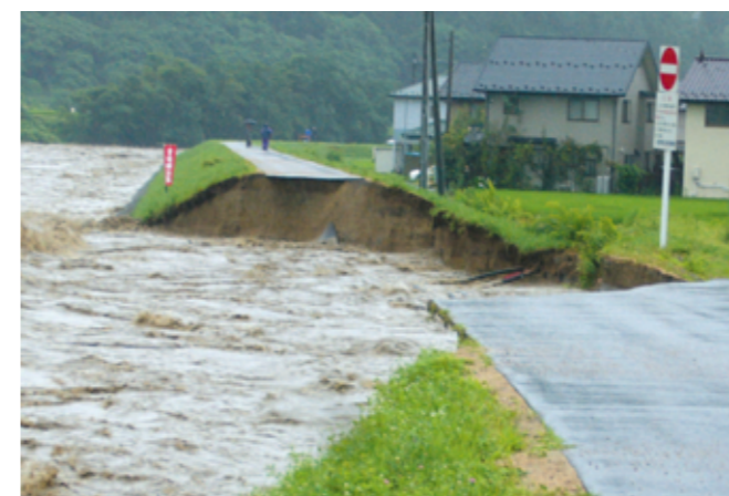
H18.7月豪雨 天竜川の破堤状況(長野県箕輪町)
