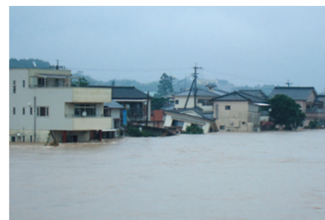
H18.7月豪雨 川内川氾濫の浸水状況(鹿児島県さつま町)
