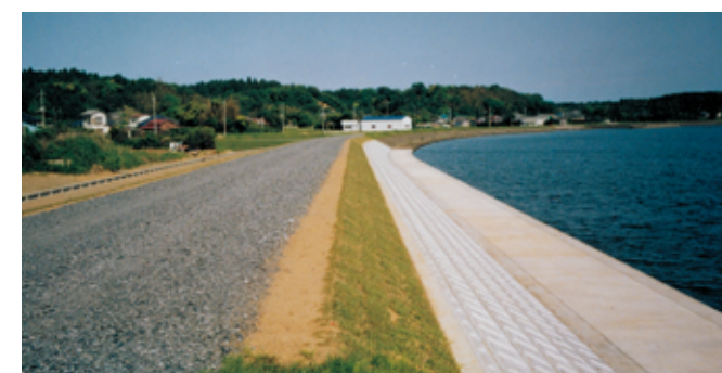
湖岸堤 (霞ヶ浦開発、水資源機構)
