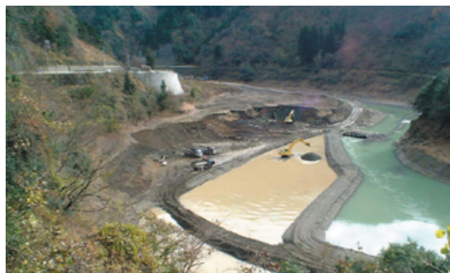
(横山ダム貯水地内掘削の様子)
