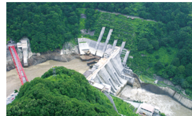
(宇奈月ダム排砂状況)
