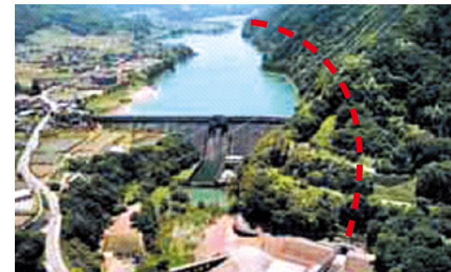
(美和ダムの土砂バイパス)
