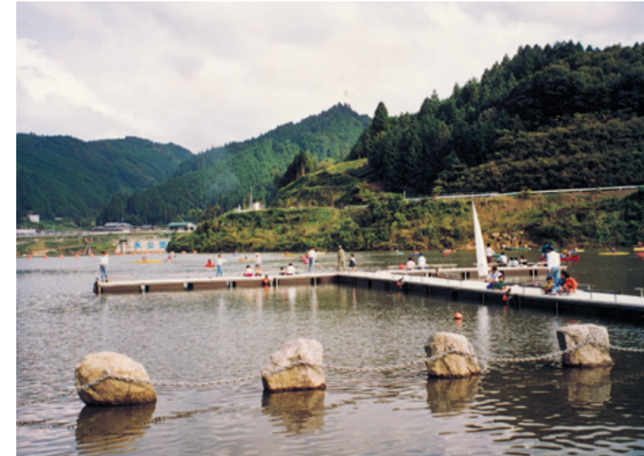
貯砂ダムにより確保された水面での親水活動
