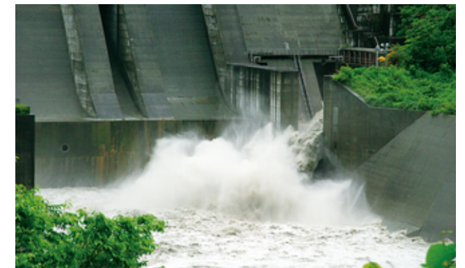
(排砂ゲートからの土砂フラッシュ状況)
