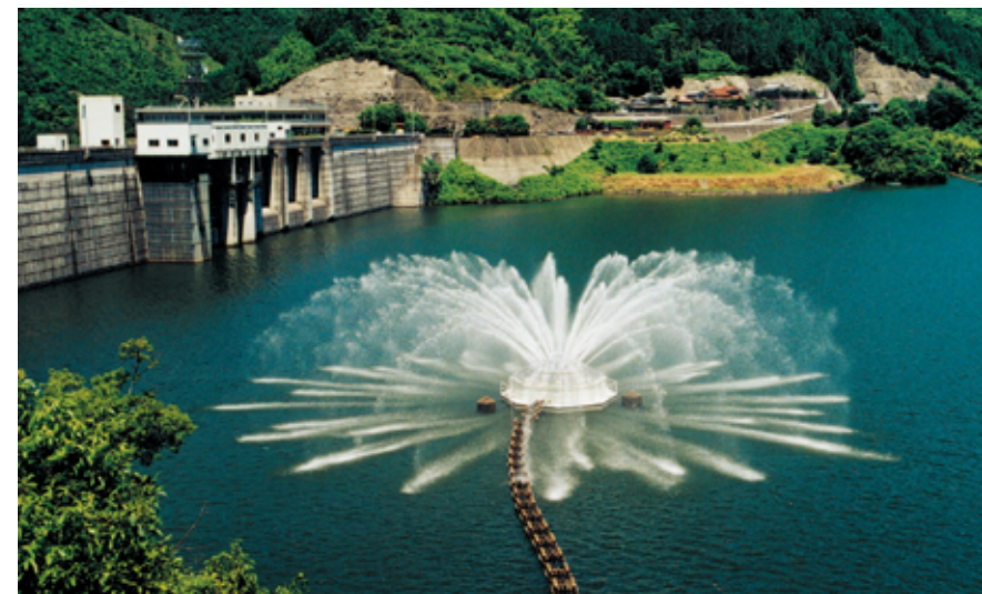
耶馬溪ダム(九州地方整備局) 噴水を兼ねた浅層曝気
