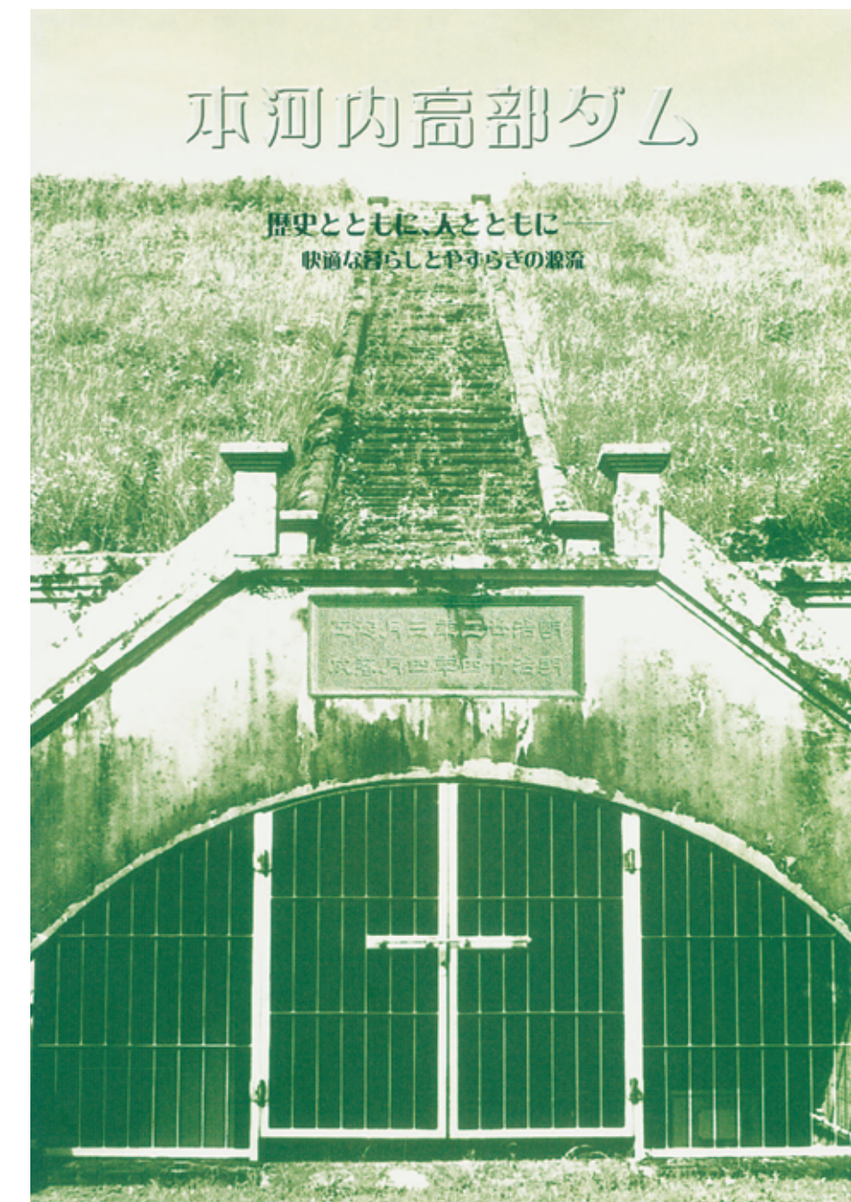
本河内高部ダム
