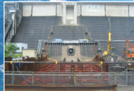
洪水吐き、ゲート等放流施設の改良及び新設
