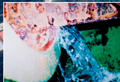
老朽化により機能劣化した低水放流設備
