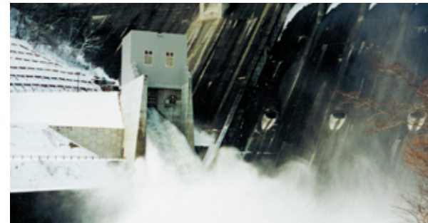
田瀬ダム (東北地方整備局)
