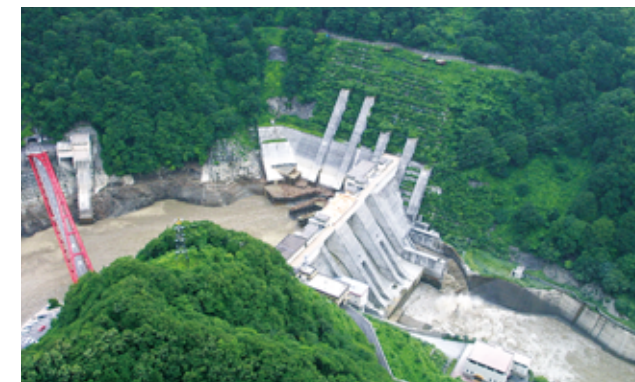
(宇奈月ダム排砂状況)
