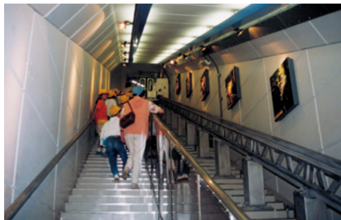
ダム堤体内の一般開放（白吉ダム、水資源機構）
