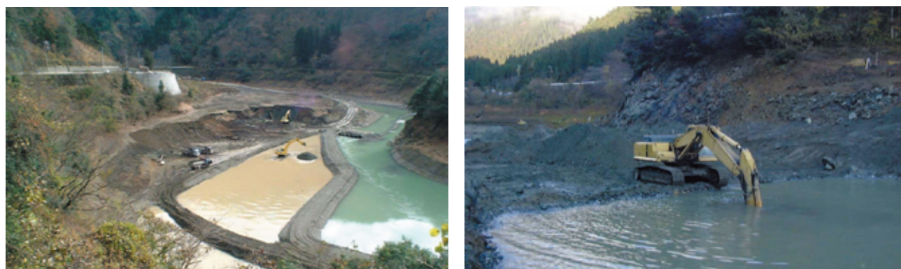
(横山ダム貯水地内掘削の様子)
