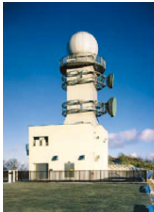
レーダー雨量計基地
