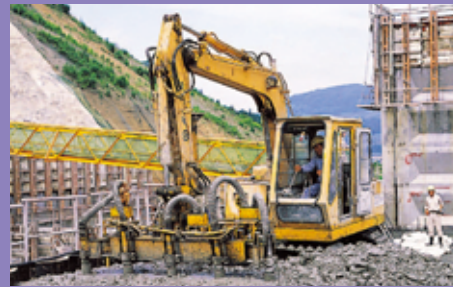
パイバックによる締め固め
