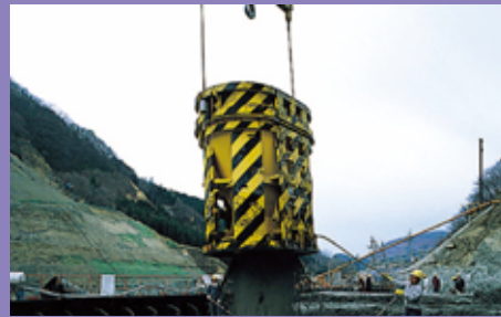
コンクリートバケット (6m³・20t)
