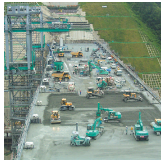
長井ダム（東北地方整備局）
