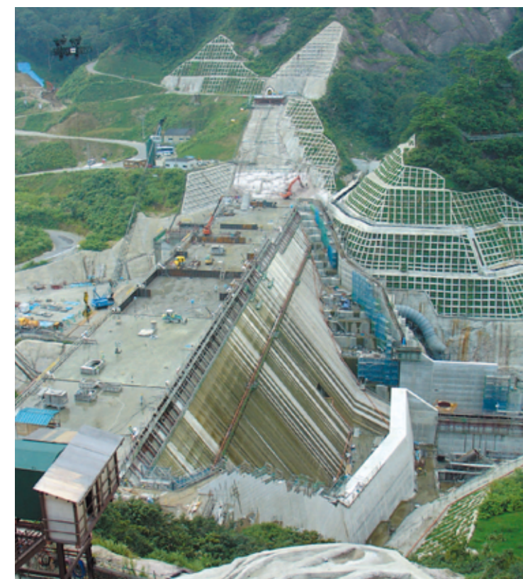
よこがわ 横川ダム (北陸地方整備局)
