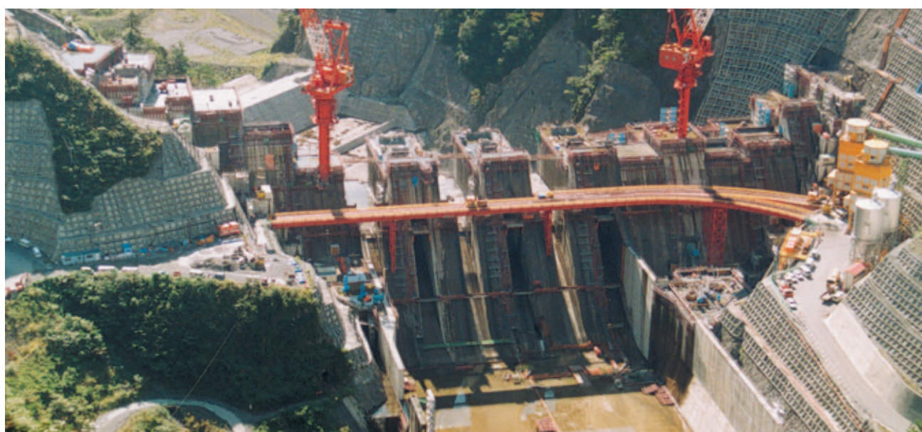
ながしま 長島ダム (中部地方整備局)
