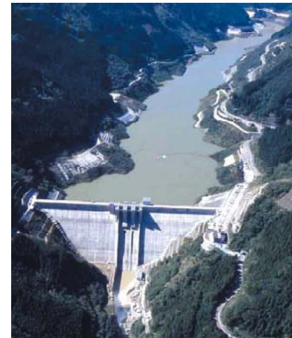
滝沢ダム(水資源機構)
