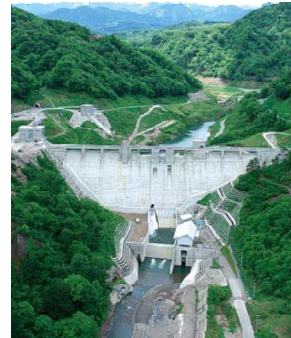
横川ダム(北陸地方整備局)
