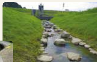
河川・水路をつなぐ樋管排水路をせせらぎ水路化
