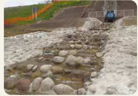
水域連続性確保策による生態系ネットワークの強化（利根運河境田樋管）
