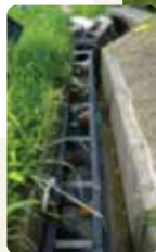
水路・水田をつなぐ簡易魚道
