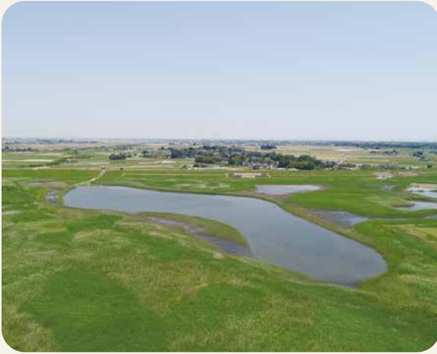
治水事業と連携した生態系ネットワーク拠点の整備（渡良瀬遊水地第2調節池）
