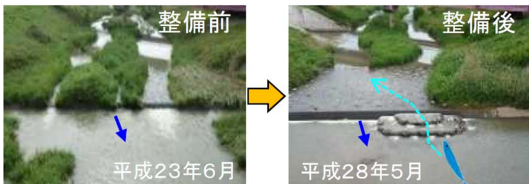
八代水門直上流の落差
