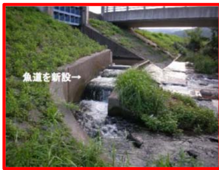
水田魚道の設置（県）
