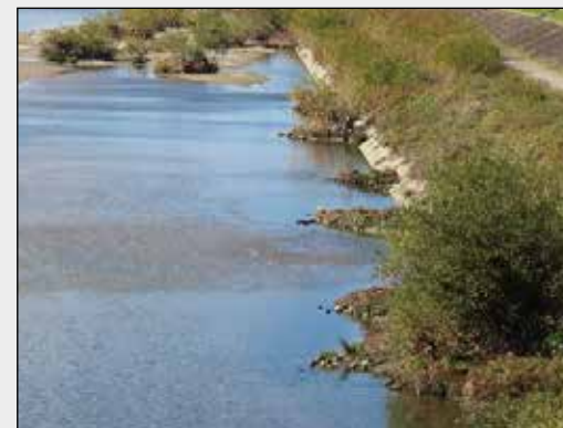
既存の護岸前面に設置した捨石工
