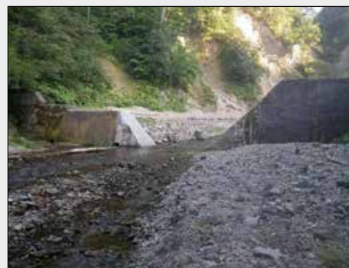
水通し部の一部を切り下げた治山ダム
