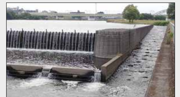
副ダムと引き込み式魚道
