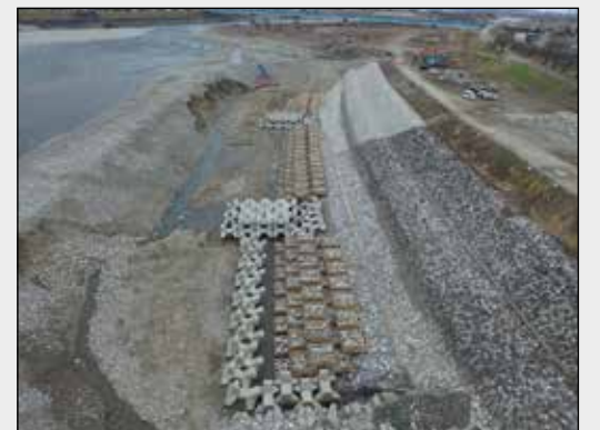
水制工施工時の状況
