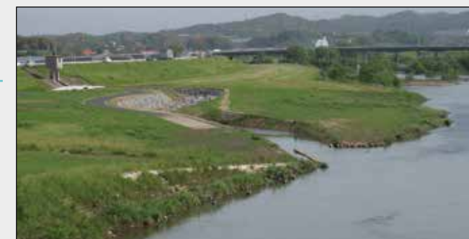
川表排水路と本川合流部に創出された環境
