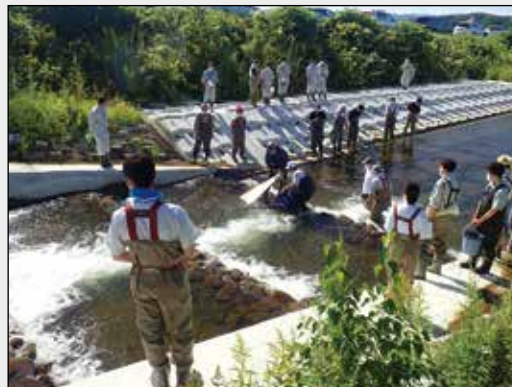
現地での技術指導の様子（魚道ワーキング）
