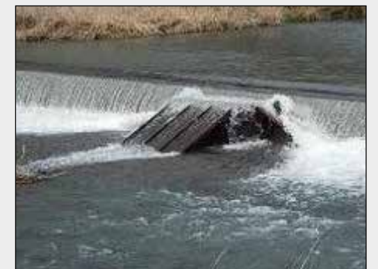
市民団体などの取組（簡易魚道の設置）
