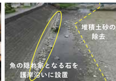
堆積土中の石を利用した 水制工の試行
