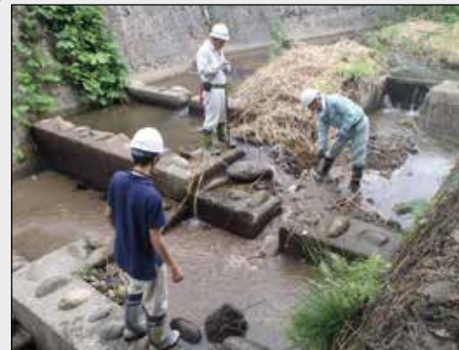
地域住民による魚道点検の様子
