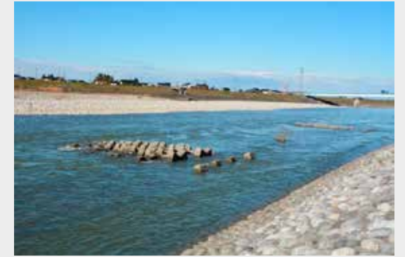
サクラマス成魚の越夏場所に設置された水制工（左：完成時 右：運用時）
