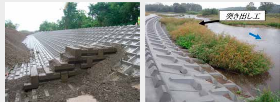
突き出し工（左：完成時 右：設置から 1 年後の状況）
