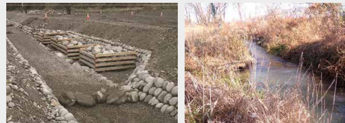
サクラマス幼魚の越冬場所に設置した木工沈床（左：完成時 右：運用時）
