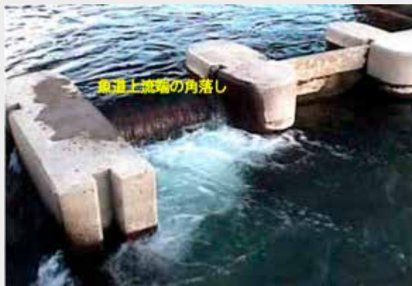
魚道上流端の角落し
