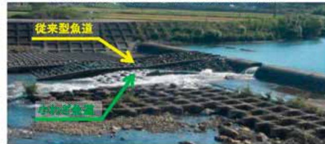
小迫堰 ～「従来型魚道」と「小わざ魚道」を併設～
