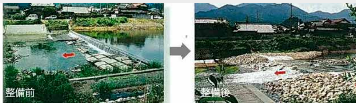
スロープ式落差工による縦断連続性の確保 出典：兵庫県（2004）ひょうご・人と自然の川づくり事例集
