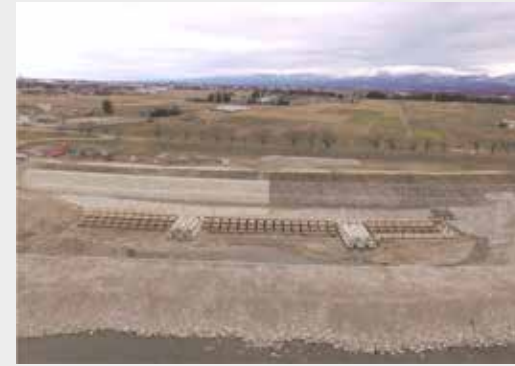
サクラマス成魚の越夏場所に設置された水制工（左：完成時 右：運用時）
