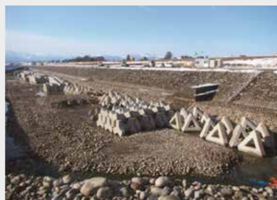
淵の中に設置したコンクリート異形ブロック
