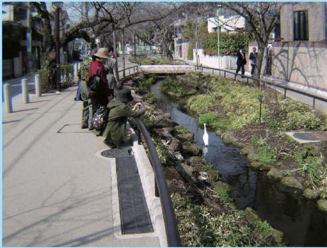
北沢川緑道(水源:下水再生水)〔東京都世田谷区〕
