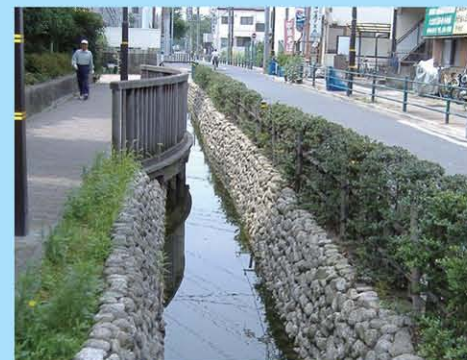
亀井堀親水水路（東京都足立区）
