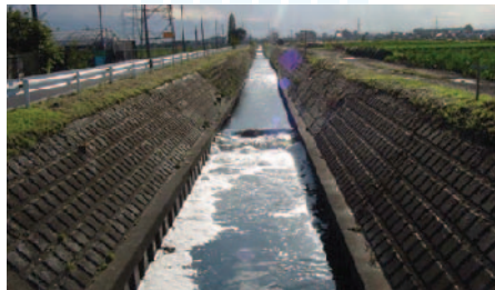
コンクリート護岸で覆われ直線化した川
