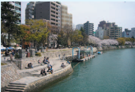
まちづくり事業と一体となった河川整備
