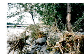
堤内への土砂流入の防止状況
