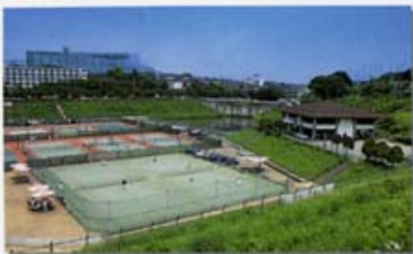
通常はテニスコートに利用している例 (霧が丘調整地・神奈川県)
