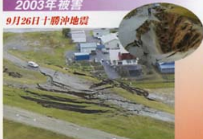
十勝川堤防右岸豊頃町（北海道）
