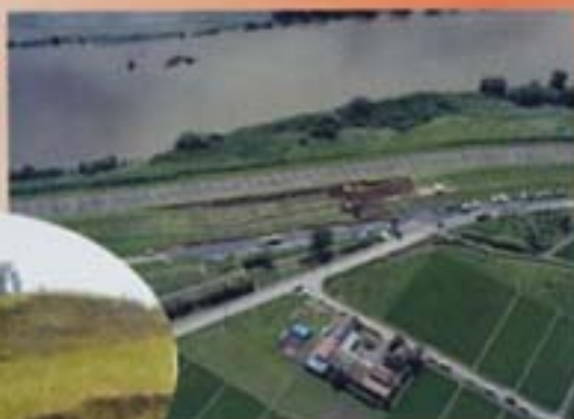
鳴瀬川右岸堤防鹿島台町（宮城県）
