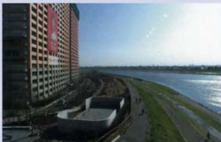
高規格堤防上に建設中の民間マンション 江戸川 千葉県市川市
