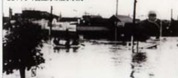
S24キティ台風時の浸水状況
