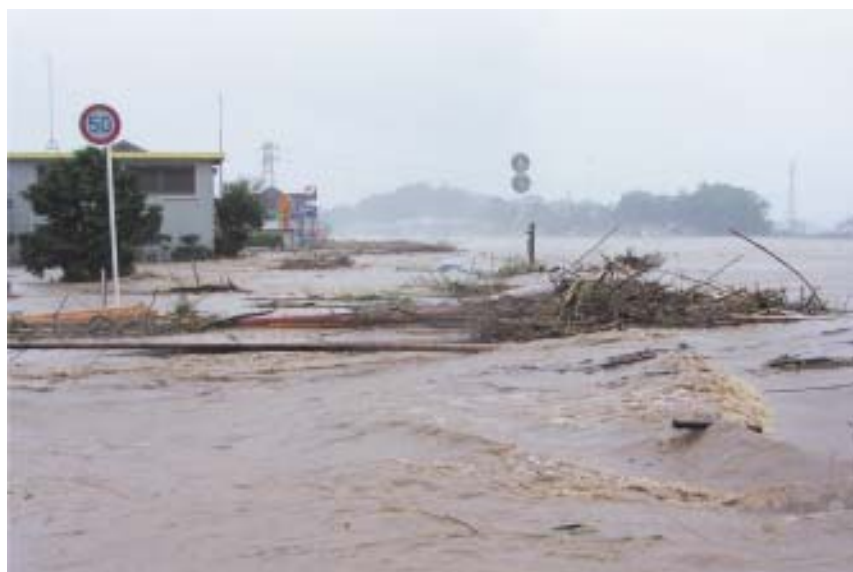
五ヶ瀬川（宮崎県） 越水状況
