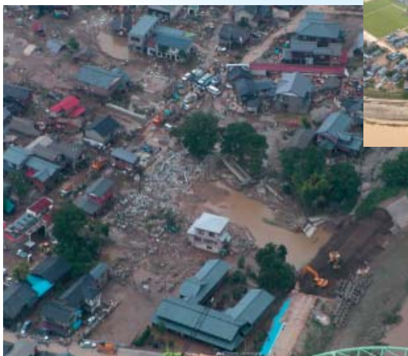
刈谷田川破堤後の状況（新潟県）
