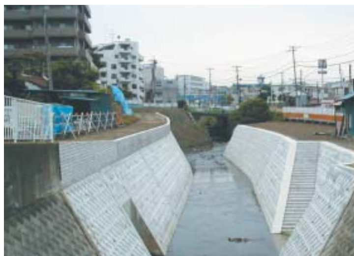
本川河道改修後
