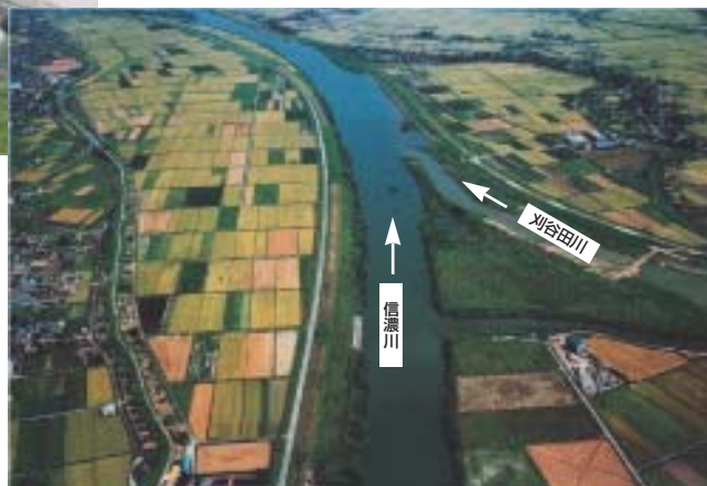
河川災害復旧等関連緊急事業実施区間の一部 信濃川と刈谷田川の合流部 (新潟県)
