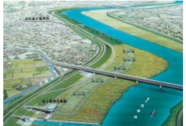
古ヶ崎浄化施設（江戸川）
