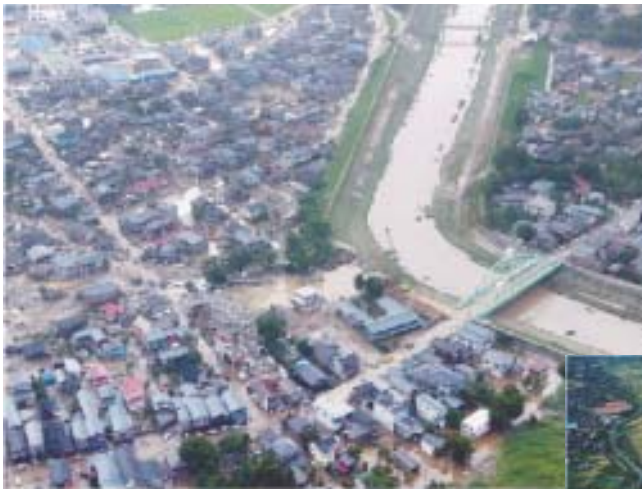
破堤した刈谷田川（新潟県）
