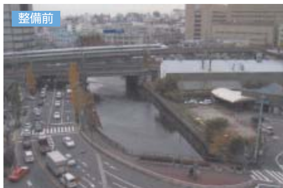
目黒川（東京都） 防潮堤防の整備
