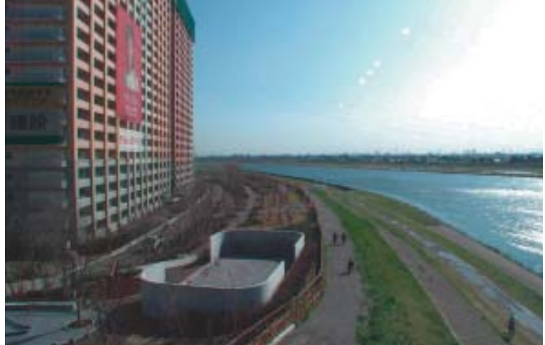
高規格堤防上に建設された民間マンション 江戸川 千葉県市川市
