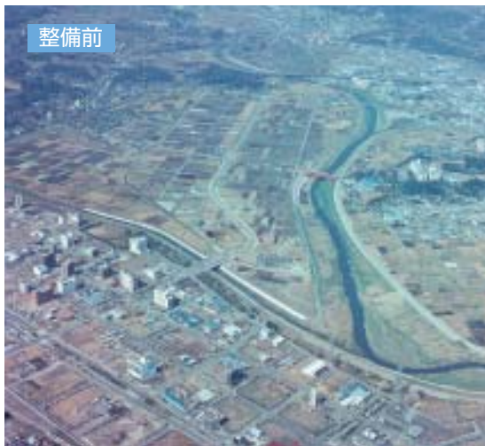
鶴見川多目的遊水地（神奈川県横浜市）
