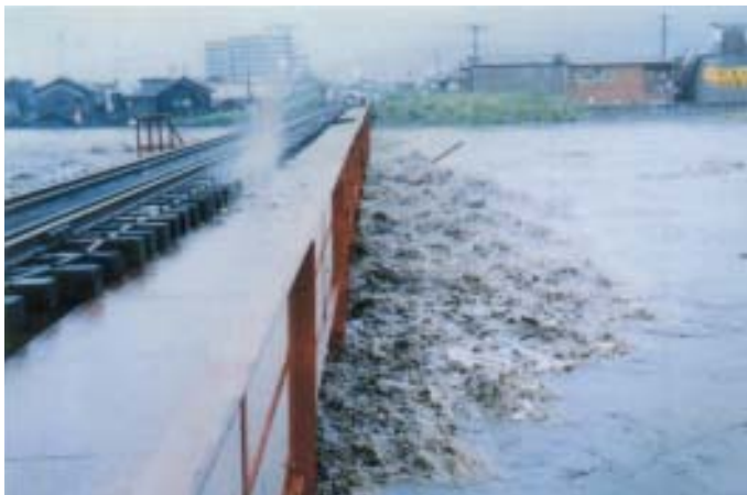
JR白川橋梁 白川（熊本県）
