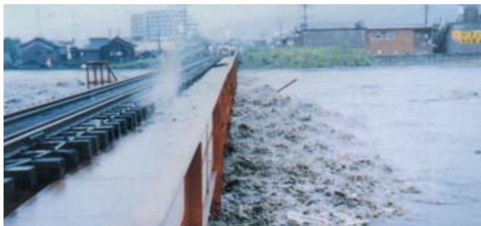
JR白川第一橋梁 白川（熊本県）
