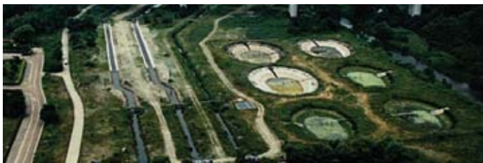
■空空間の形状・流量・流速などをコントロールできる実験河川
