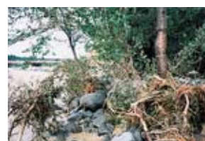
堤内への土砂流入の防止状況
